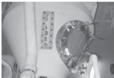
(B) 点検口設置→清掃容易化
