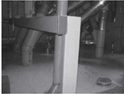
(B) 改善後： 端面にカバー設置
